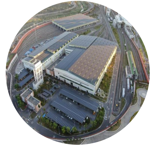
Taichung Metro Beitun Depot
